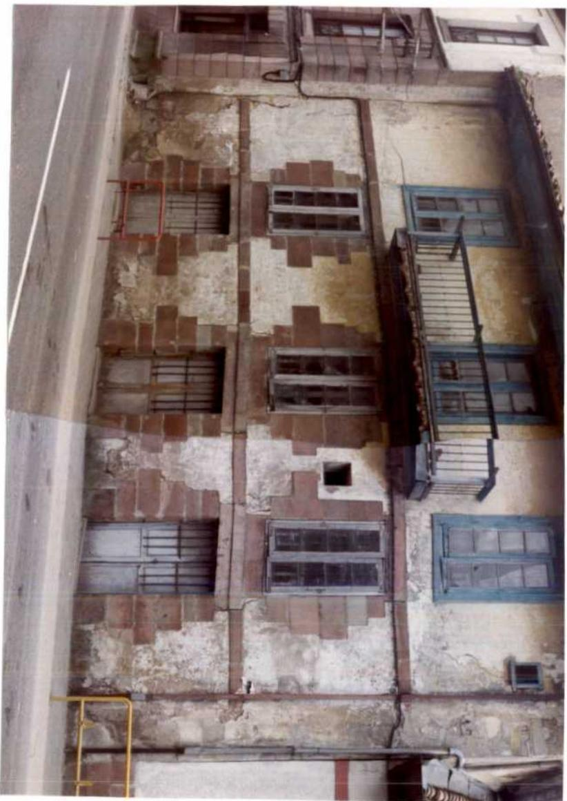
Aspecto de una de las casas afectada por los hundimientos de galerías de la antigua explotación de sal
